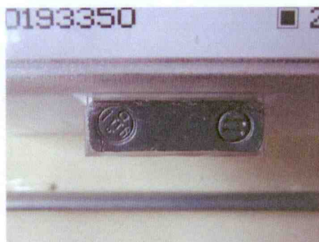
Рисунок 3 - Место пломбирования сумматора счетчика
